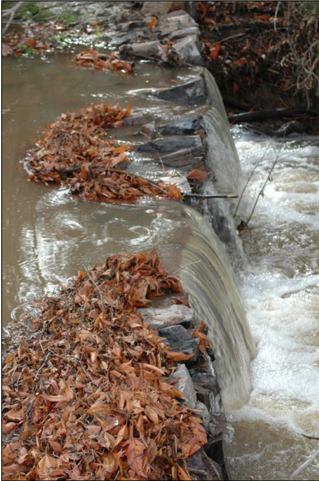
Trincheras con agua fluyendo.
