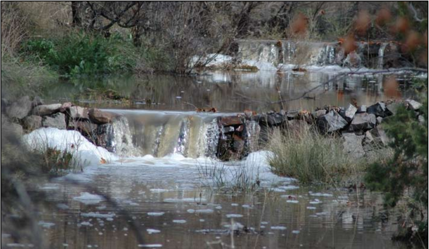
Trincheras después de la corriente.
