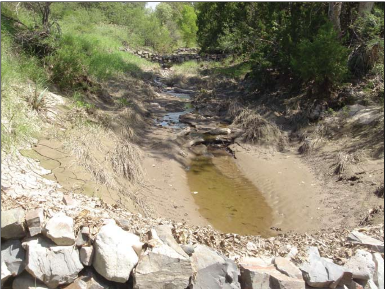
Trincheras perpendiculares al cauce del arroyo.
