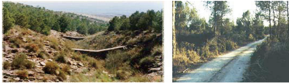
Figura 3 —Obras hidrológicas y mejora de caminos en la zona de estudio.
